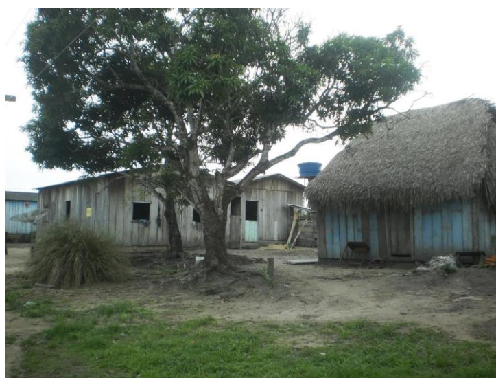
Figura 4.12: Local da instalação na comunidade, com visto da caixa ao fundo
