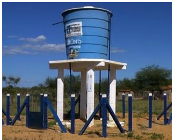
Figura 4.2: Caixa d'água de 10.000 litros para abastecimento central da comunidade
