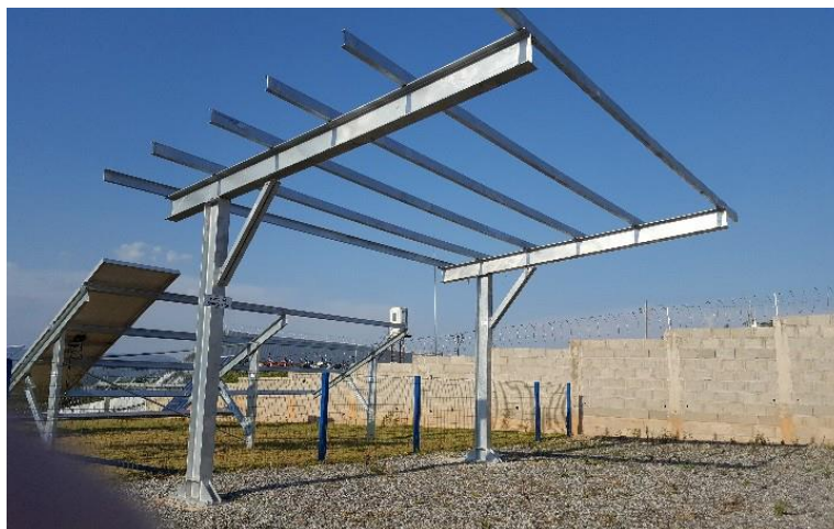
Figura 2.14: Exemplo de estruturas de fixação para estacionamento
