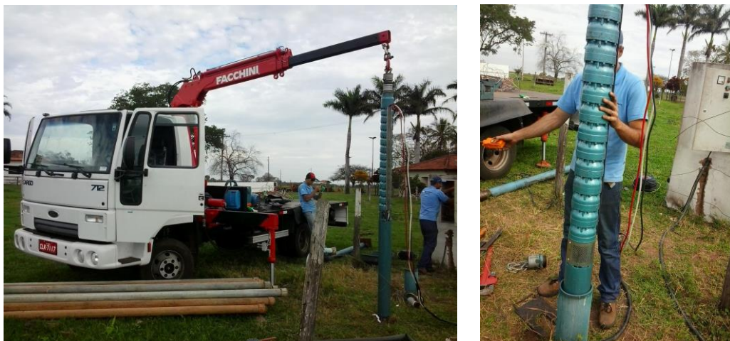
Figura 2.8: Exemplo de instalação de uma bomba submersível CA de vários estágios
